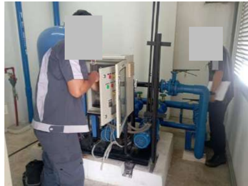
รูปที่ 2-51 การตรวจสอบระบบปั๊มสูบน้ำและเส้นท่อของโครงการ
