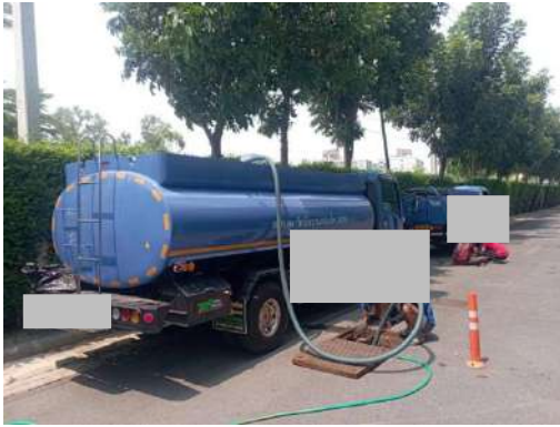
รูปที่ 2-22 ประสานงานผู้รับเหมาเข้ามาสูบกากตะกอนจากระบบบำบัดน้ำเสียของโครงการ
