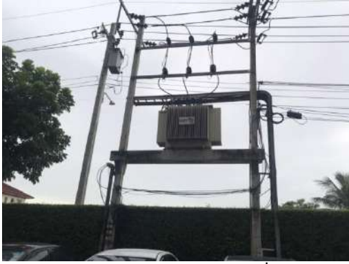
รูปที่ 2-40 หม้อแปลงไฟฟ้าหลักของโครงการ
