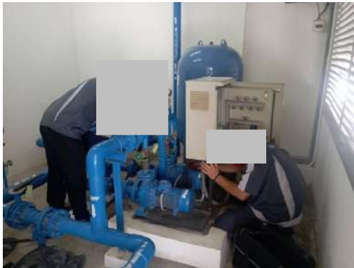
รูปที่ 2-51 การตรวจสอบระบบปั๊มสูบน้ำและเส้นท่อของโครงการ
